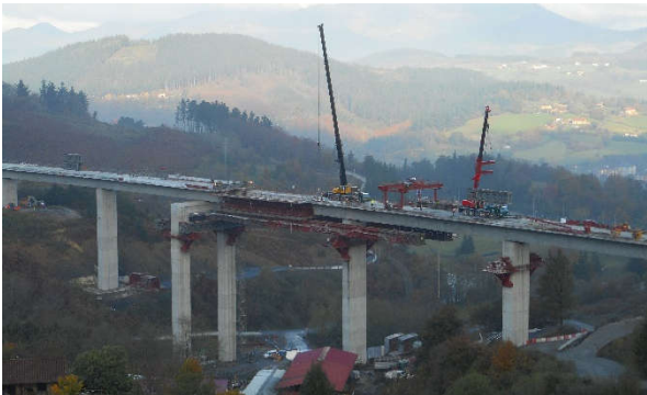
Figura 17. Vista de fase 11 de tablero (cierre)
