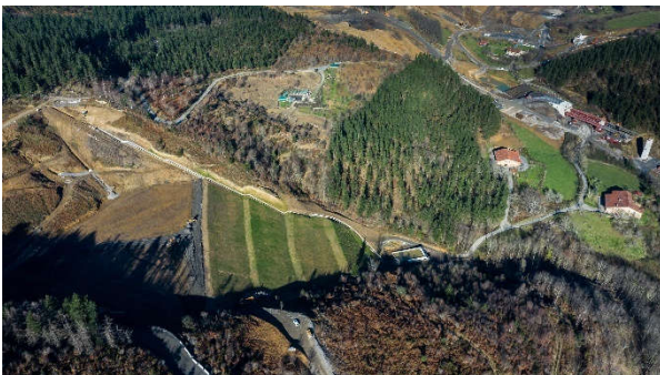
Figura 21. Vertedero de Larrapitxi tras su desmontaje y saneo, con estribo 2 y pila 14 en la parte derecha de la imagen.
