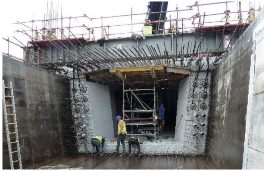
Figura 27. Vista general del frente de tesado del tablero.
