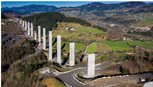
Figura 23. Vista general pilas 2 a 14.
