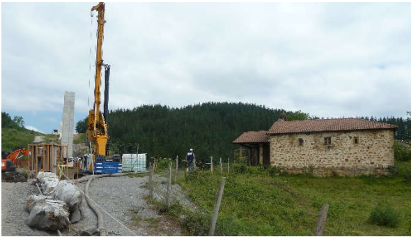
Figura 20. Ermita de Santa Catalina durante la ejecución de la cimentación de la pila 8 del viaducto de Kinatoi.
