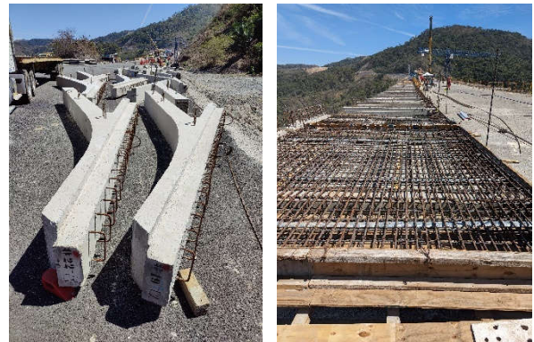
Figura 16. Jabalcones (izquierda) y voladizos laterales de tablero (derecha).
