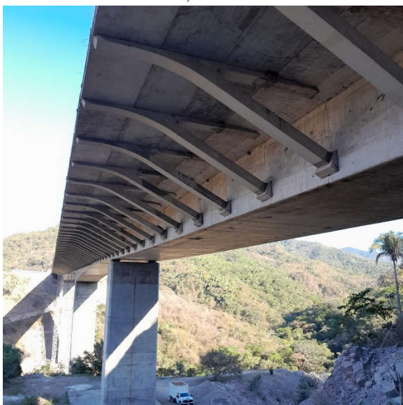
Figura 21. Vista general del puente terminado.
