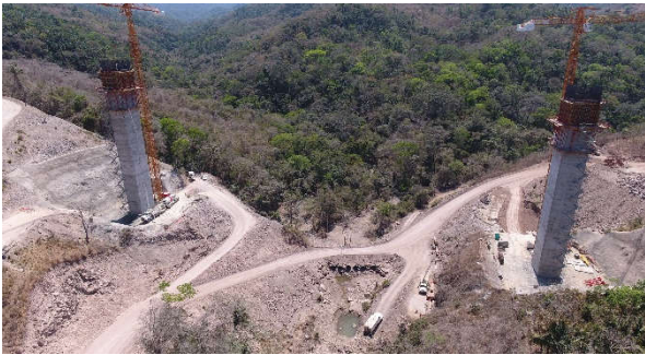
Figura 13. Alzados de pilas P3 y P4 en ejecución.
