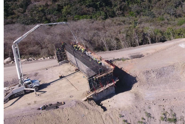
Figura 10. Vista general construcción caballete 1
