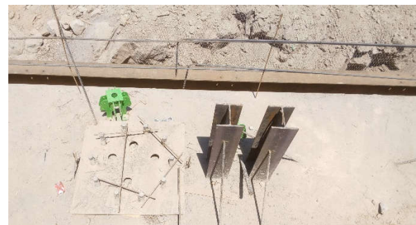
Figura 11. Perfiles embebidos para conexión provisional tablero-caballete
