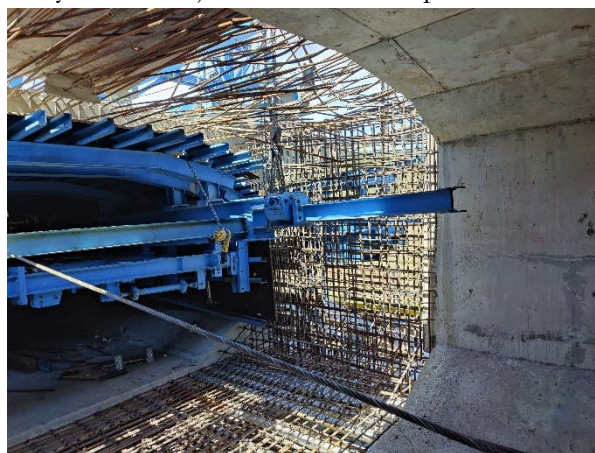
Figura 18. Preparación de ferralla para dovela de cierre
