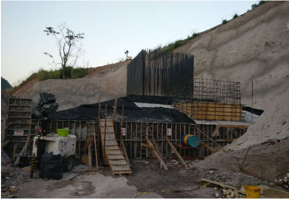
Figura 12. Cimentación de pila P4
