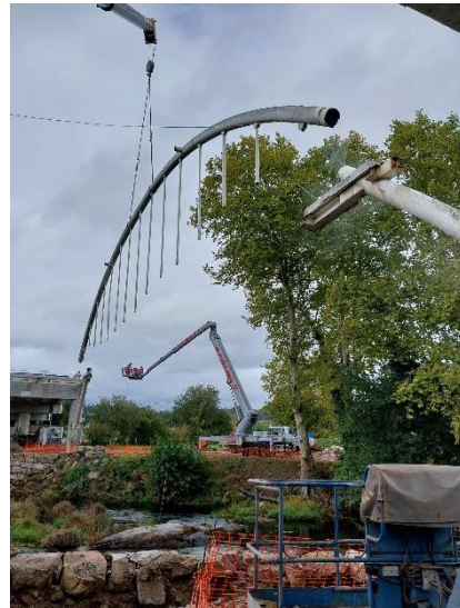
Figura 9. Desmontaje arco.
