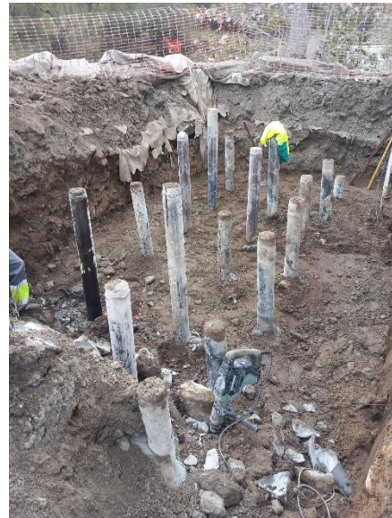
Figura 12. Micropilotes.
