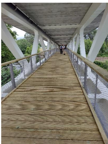
Figura 22. Detalle barandilla pasarela.
