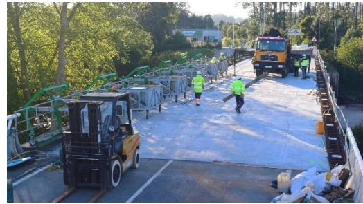
Figura 18. Hormigonado losa superior.
