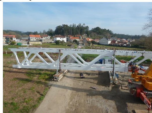
Figura 14. Ensamblaje celosías.
