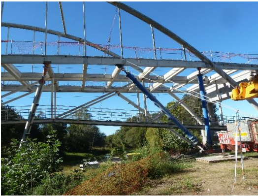
Figura 7. Fin desmontaje losa.
