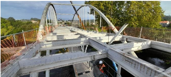
Figura 6. Desmontaje losa.
