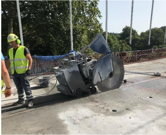
Figura 5. Corte losa superior.
