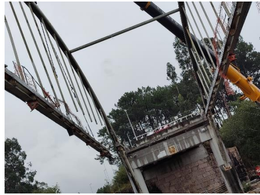
Figura 8. Desmontaje tablero.
