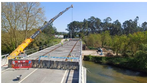
Figura 17. Montaje prelosas.
