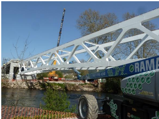
Figura 16. Ensamblaje celosías.
