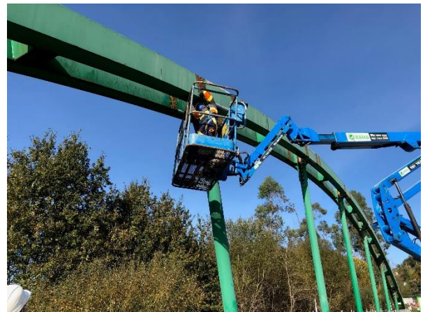
Figura 7. Ensayo soldadura arco.
