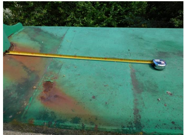
Figura 4. Fisura cajón derecho.
