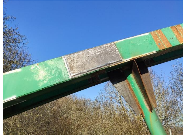
Figura 9. Refuerzo arco y péndolas.
