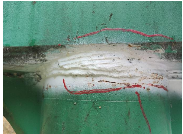
Figura 6. Ensayo soldadura péndola.
