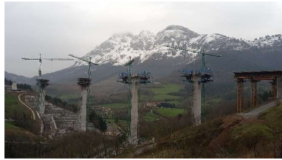
Figura 4. Pilas acabadas y primeras dovelas en construcción.
