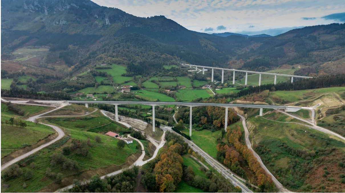
Figura 1. Viaducto de Zumelegui finalizado
