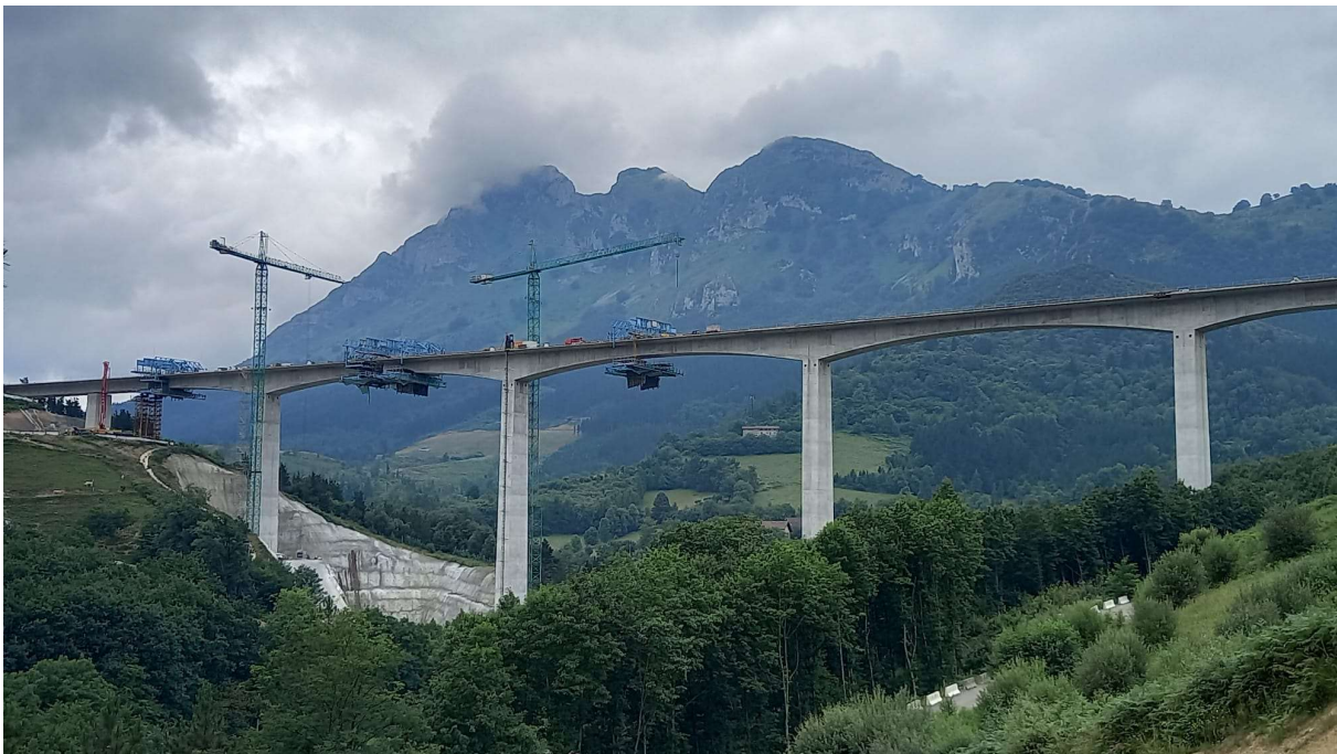
Figura 15. Dovela de cierre entre P4 y P5
