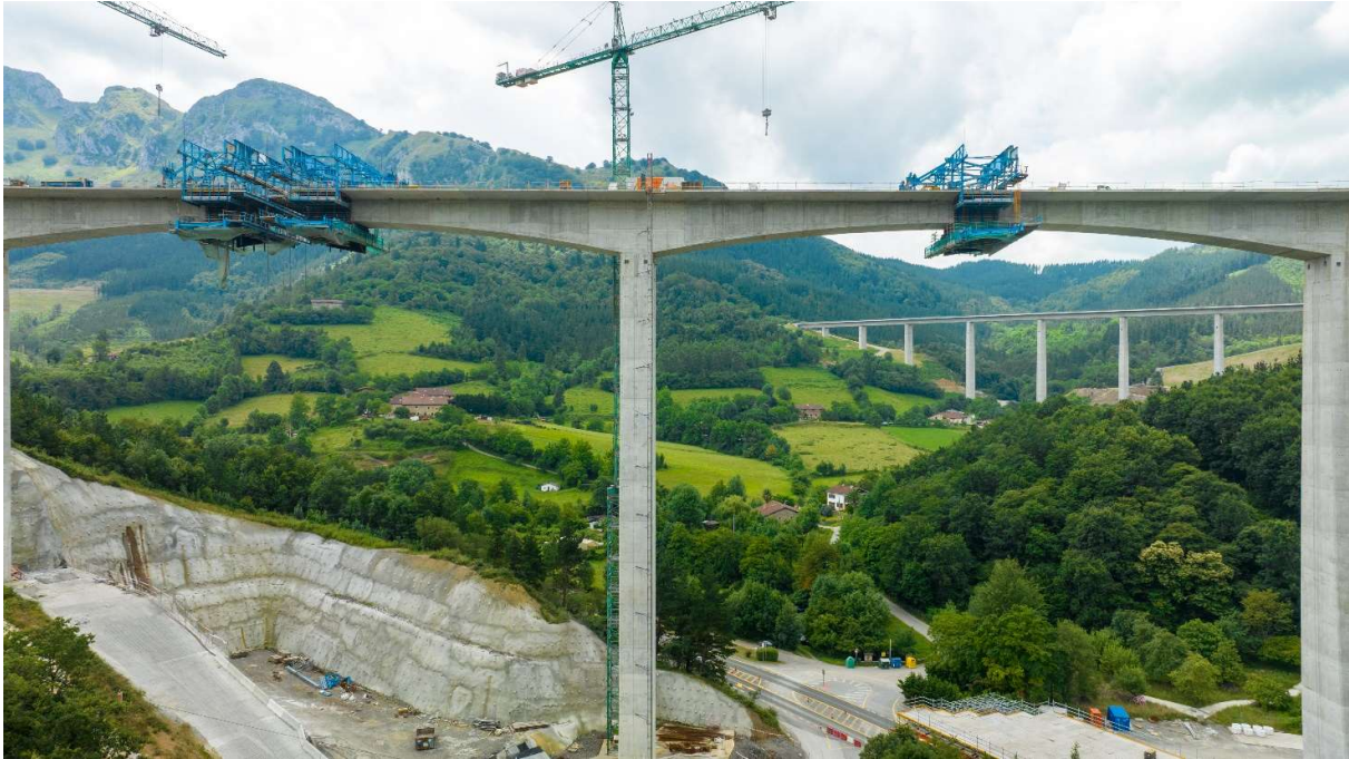
Figura 14. Dovela de cierre entre P3 y P4
