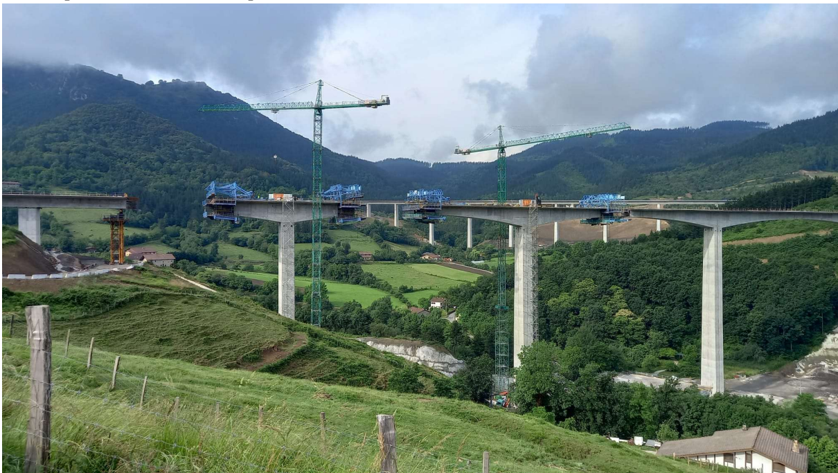
Figura 13. Parejas de carros en pilas 4 y 5
