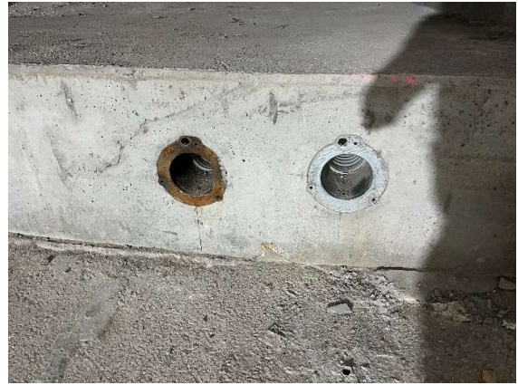
Figura 9. Placa de anclaje de reserva.
