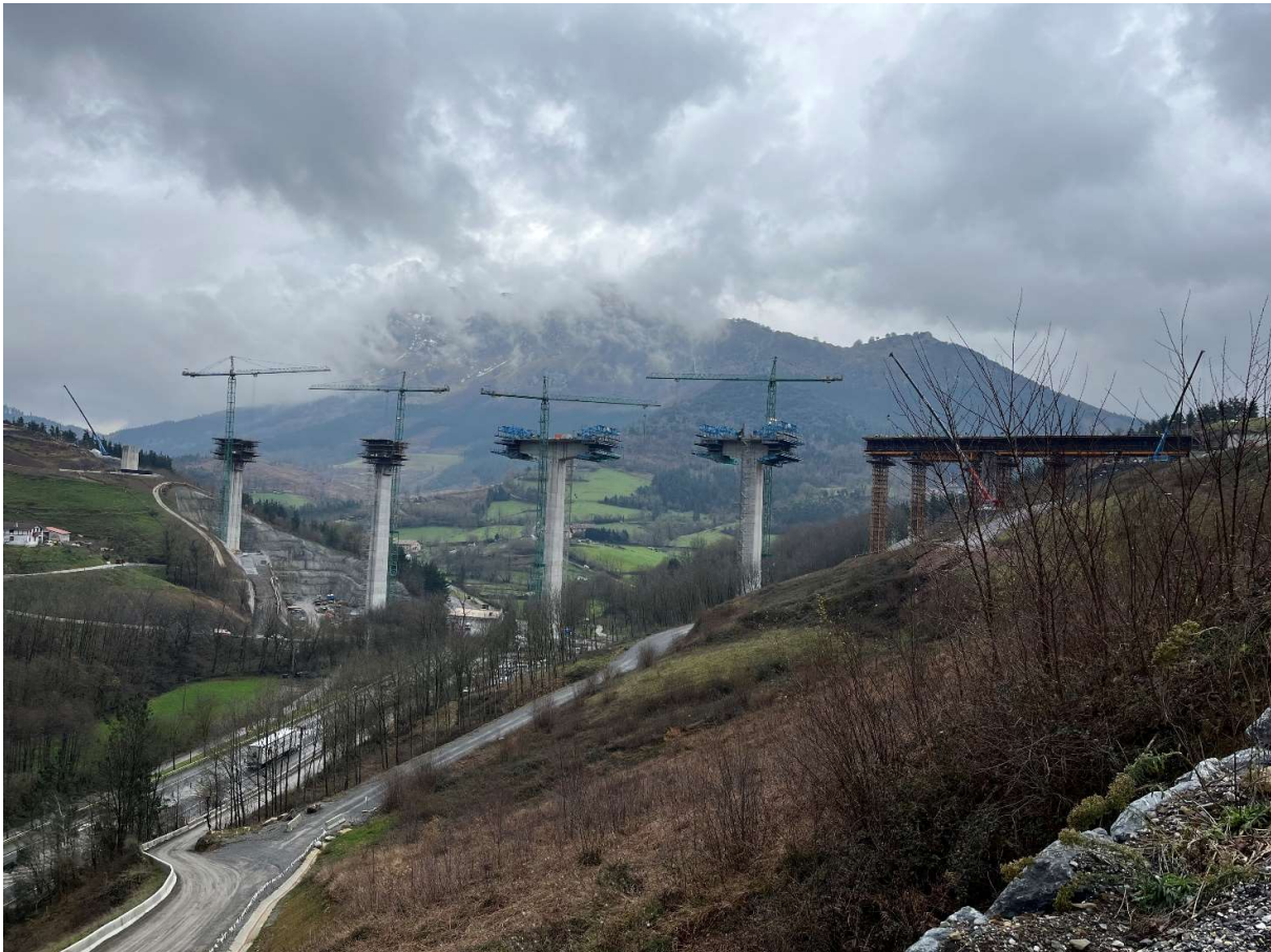
Figura 11. Parejas de carros en pilas 2 y 3
