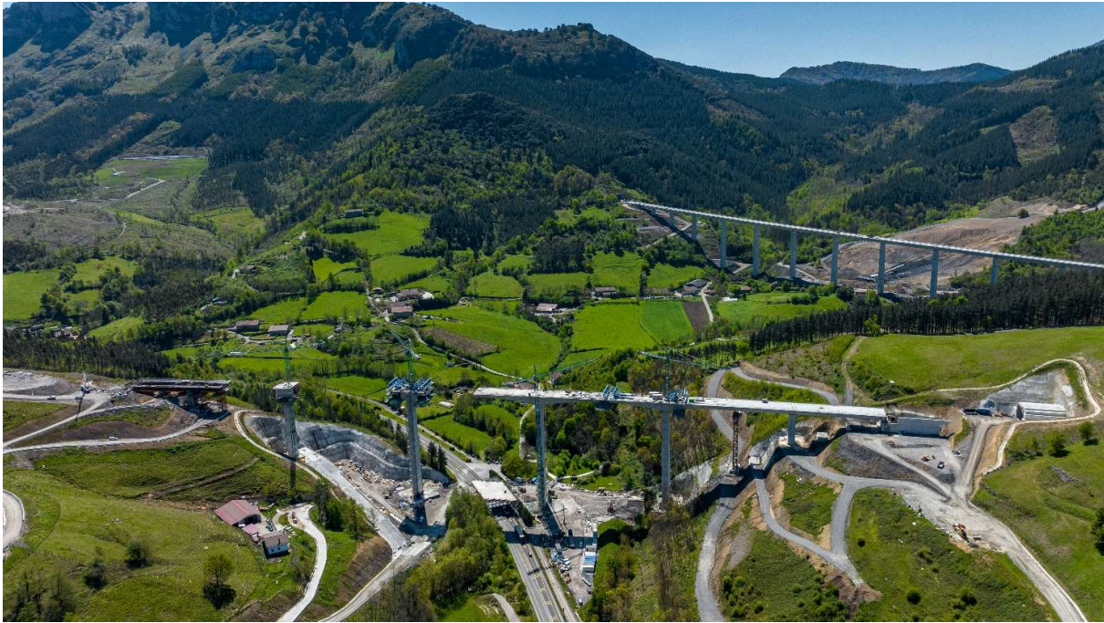
Figura 12. Dovela de cierre entre P2 y P3
