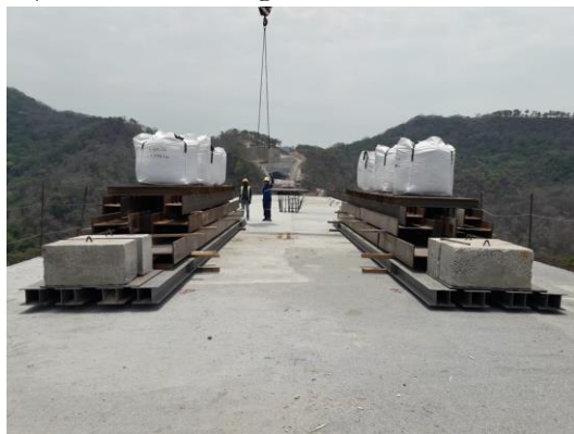
Figura 10. Prueba de carga.
