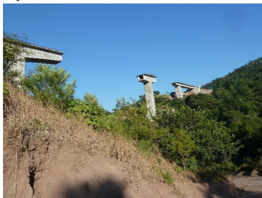
Figura 11. Estado de la obra.
