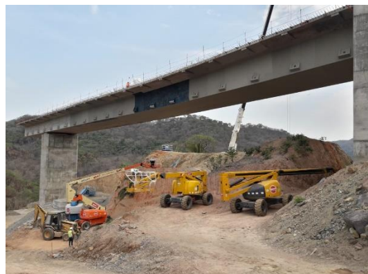
Figura 9. Refuerzo fibra de carbono.
