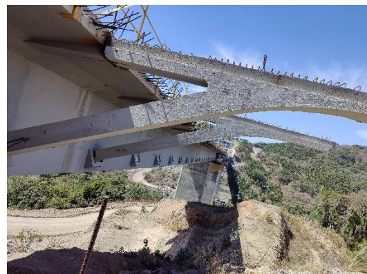
Figura 14. Montaje jabalcones.
