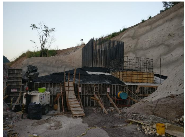
Figura 2. Colado zapata P2.
