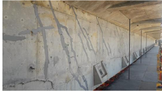
Figura 8. Inyección de fisuras.
