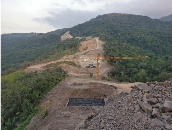
Figura 8. Zona de implantación de la estructura en el inicio de las obras.
