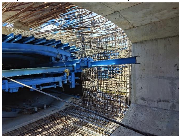
Figura 18. Preparación de ferralla para dovela de cierre
