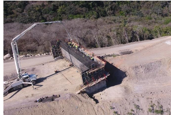
Figura 10. Vista general construcción caballete 1
