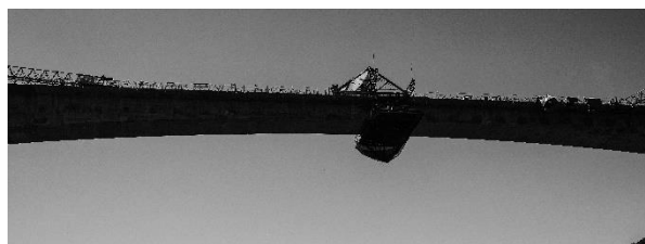
Figura 19. Vista general del hormigonado de la dovela de cierre del vano 3.
