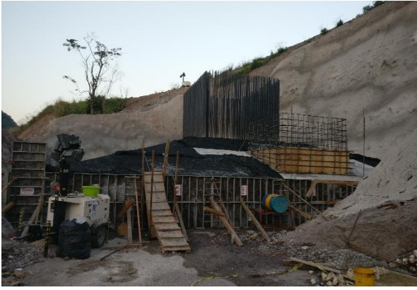
Figura 12. Cimentación de pila P4
