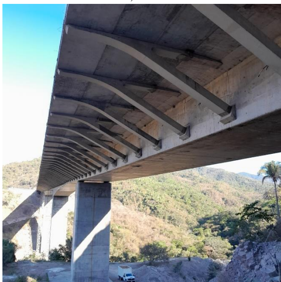
Figura 21. Vista general del puente terminado.
