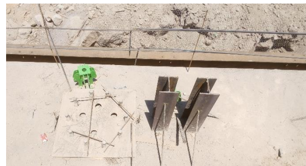
Figura 11. Perfiles embebidos para conexión provisional tablero-caballete
