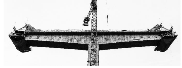
Figura 15. Vista general del avance en voladizo del tablero
