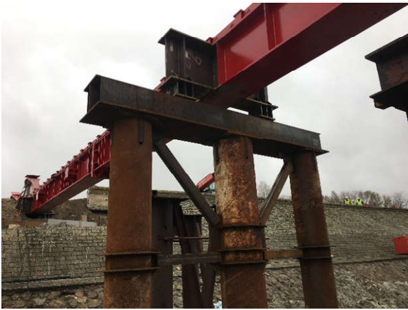
Figura 22. Nuevos grupos pilotes ejecutados
