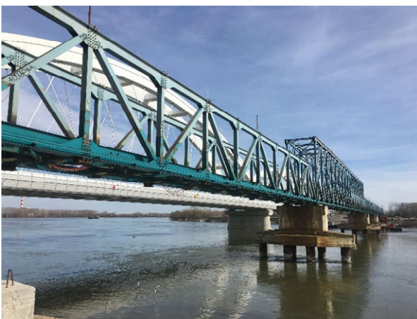
Figura 3. Nuevo puente Zezelj tras MD-88
