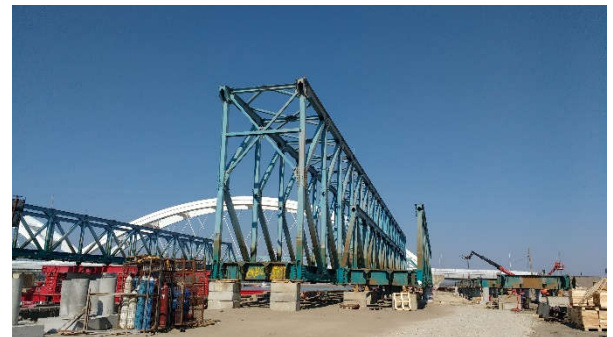
Figura 31. Vanos 2, 4 y 5 durante desmontaje
