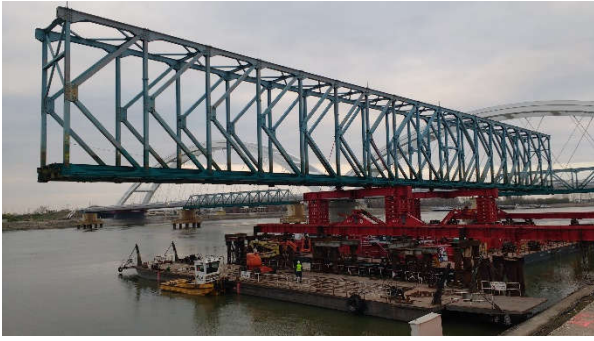
Figura 27. Posicionamiento de pontona en el muelle. Vano 4
