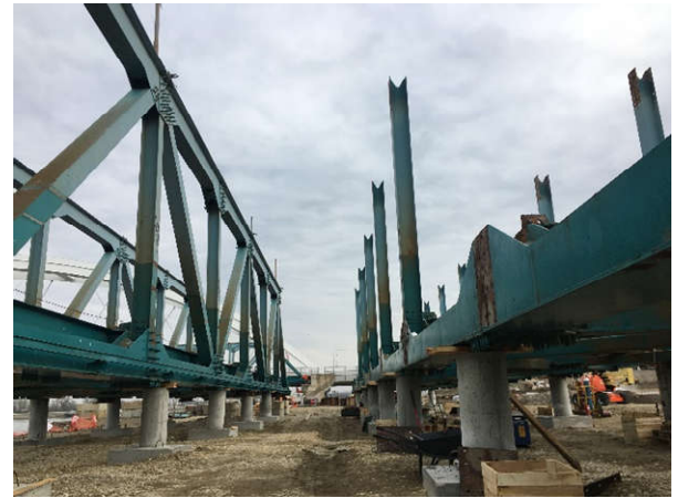
Figura 30. Vanos 2 y 5 sobre plintos durante desmontaje
