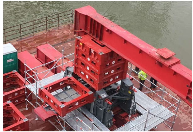
Figura 13. Elevación de cassette en Megajack
