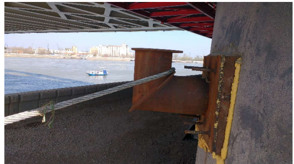
Figura 9. Punto de amarre en estribo
