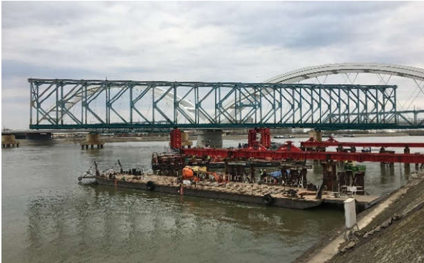
Figura 16. Transporte vano 4
