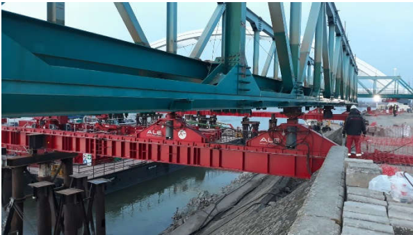
Figura 29. Deslizamiento vano 2
