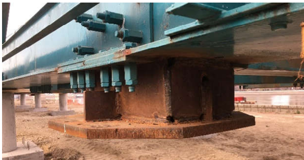
Figura 11. Pieza interfaz entre pontona-estructura
