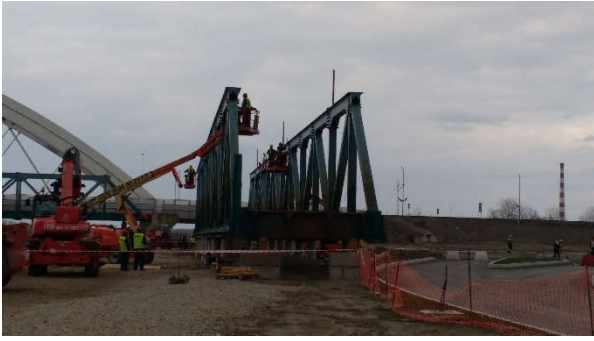
Figura 33. Desmontaje vano 2
