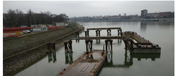
Figura 19 Estado original muelle
