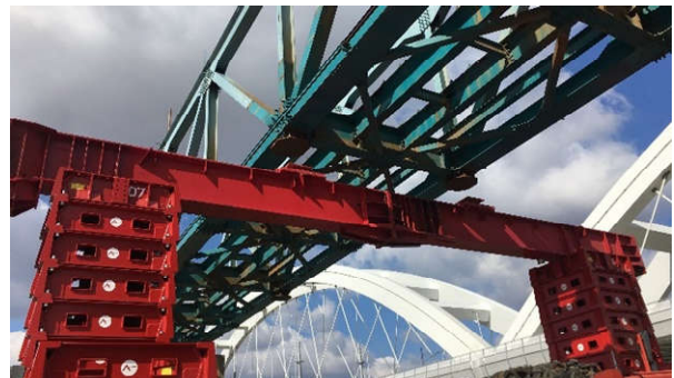
Figura 10. Colocación de pontona en posición
