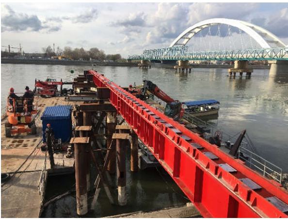
Figura 23. Vista general muelle descarga (1)
