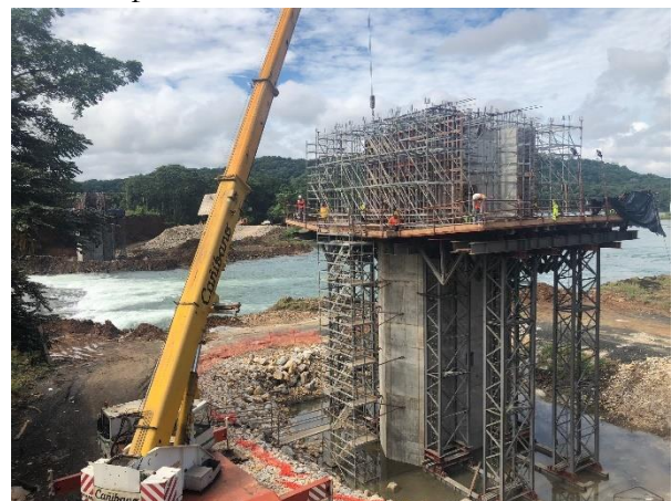
Figura 6. Cimbra para dovelas 0 y 1.
