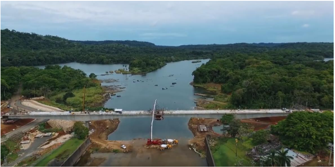
Figura 11. Hormigonado de dovela de cierre
