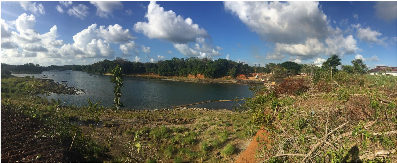
Figura 1. Emplazamiento del nuevo Puente sobre el río Chagres
