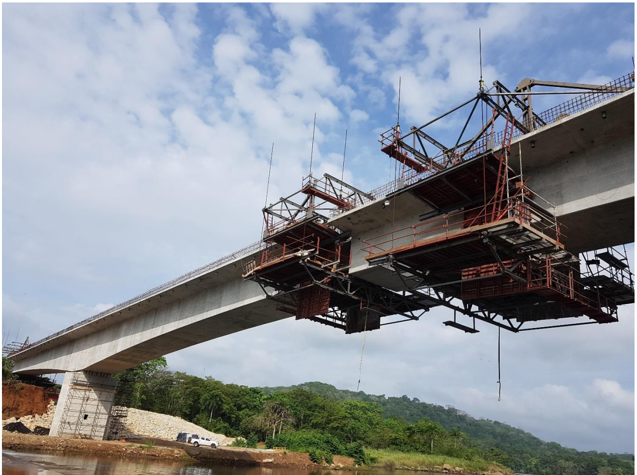
Figura 10. Hormigonado de última dovela antes del cierre.
