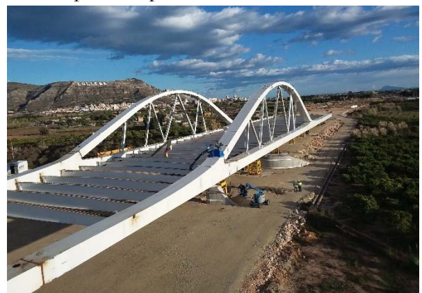
Figura 20. Montaje de estructura metálica sobre apeos provisionales.
