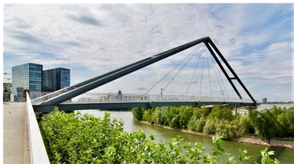
Figura 11. Pasarela peatonal y ciclista Hafenbrücke en Düsseldorf (Alemania). Arco triangular.
