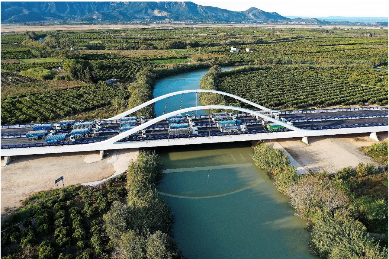
Figura 1. Vista general del Viaducto durante el desarrollo de la prueba de carga.
