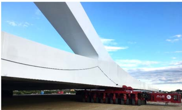
Figura 16. Apoyo del tablero sobre plataforma SPMT durante el lanzamiento.
