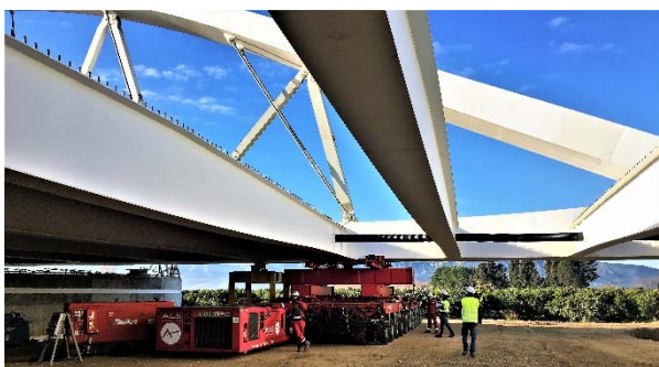
Figura 17. Apoyo del tablero sobre plataforma SPMT durante el lanzamiento.
