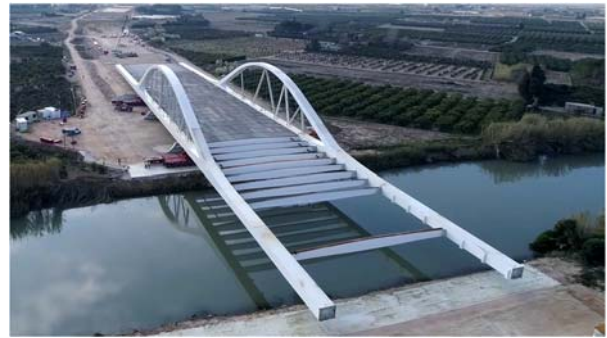
Figura 18. Fase de máximo voladizo del lanzamiento.
