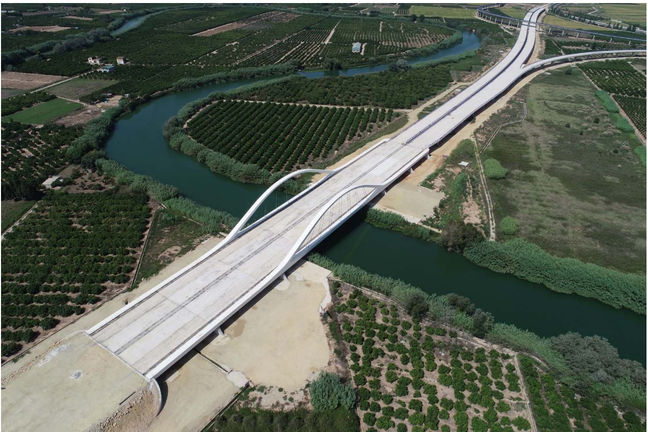
Figura 10. Vista general del Viaducto durante las últimas fases de ejecución.
