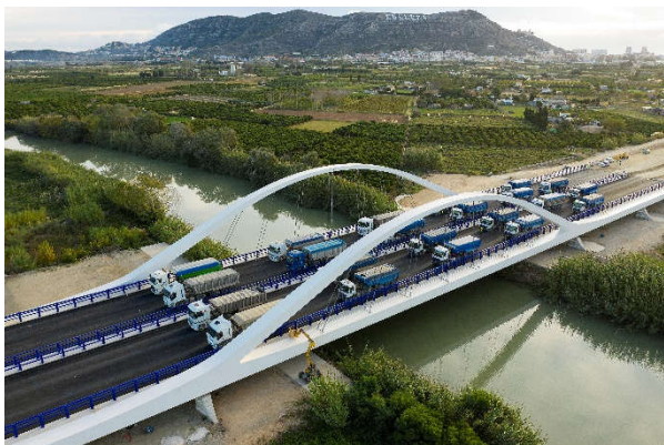
Figura 1. V-22 Durante la ejecución de la prueba de carga
