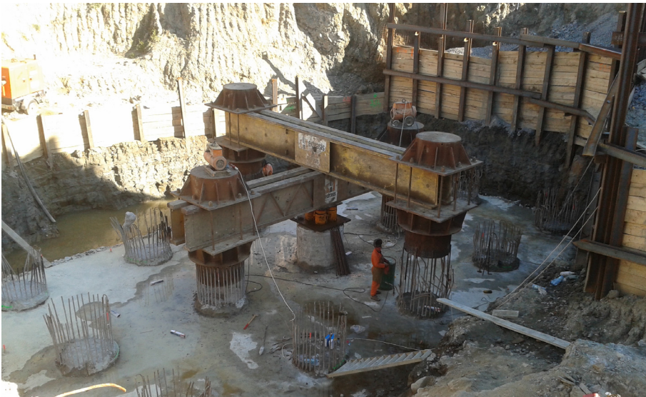
Figura 12. Prueba de carga sobre pilotes
