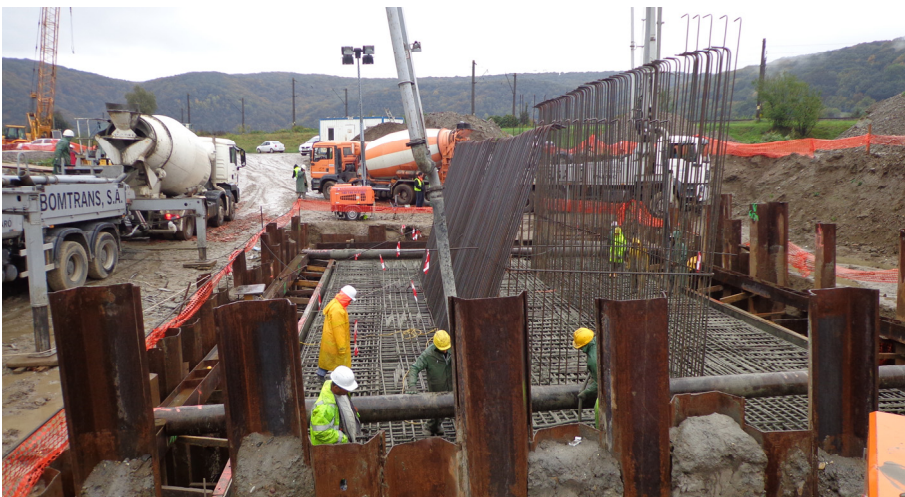
Figura 13. Ferrallado de encepado y alzado de estribo
